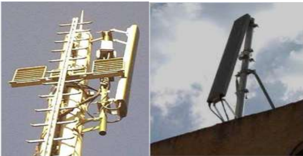
Fig. 14. Antenne directionnelle avec tilt négatif. Antenne directionnelle avec tilt positif
